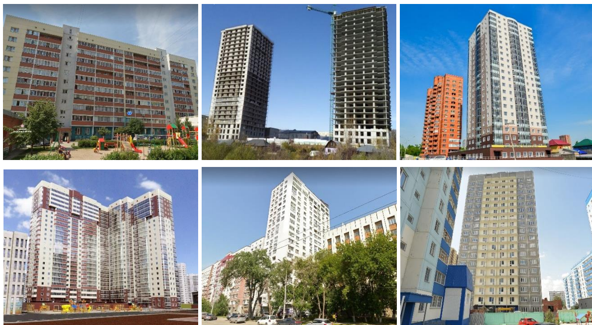
Рис. 2. Высотные здания г. Новосибирска на плитных фундаментах с инъекционными кондукторами
