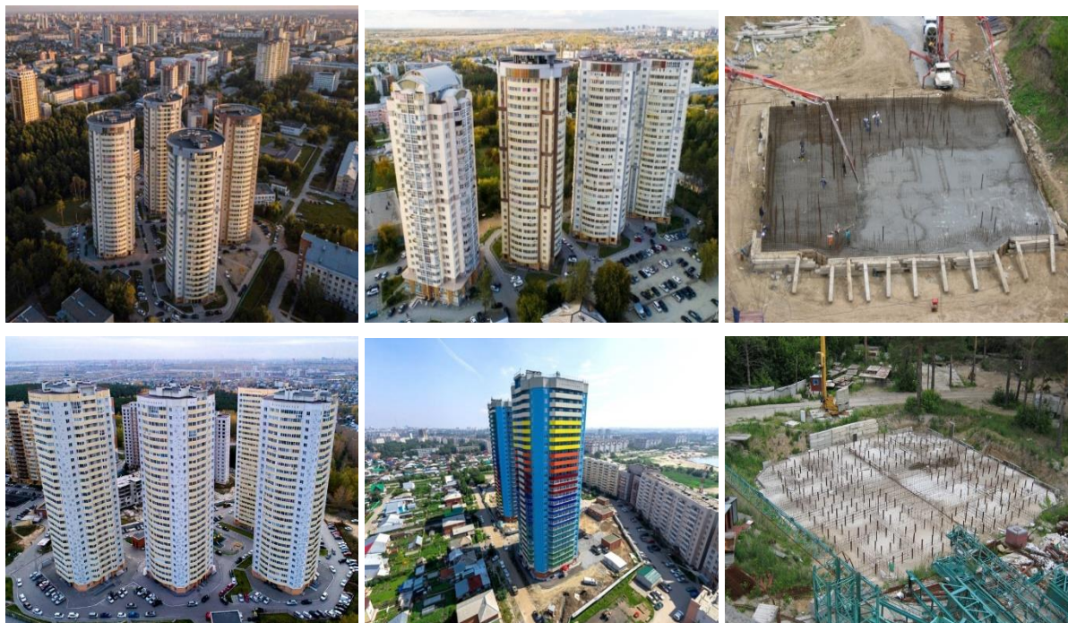
Рис. 3. Высотные здания г. Новосибирска на плитных фундаментах и устройство плитных фундаментов с инъекционными кондукторами
